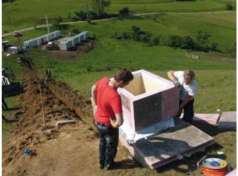
Während der Bauarbeiten
